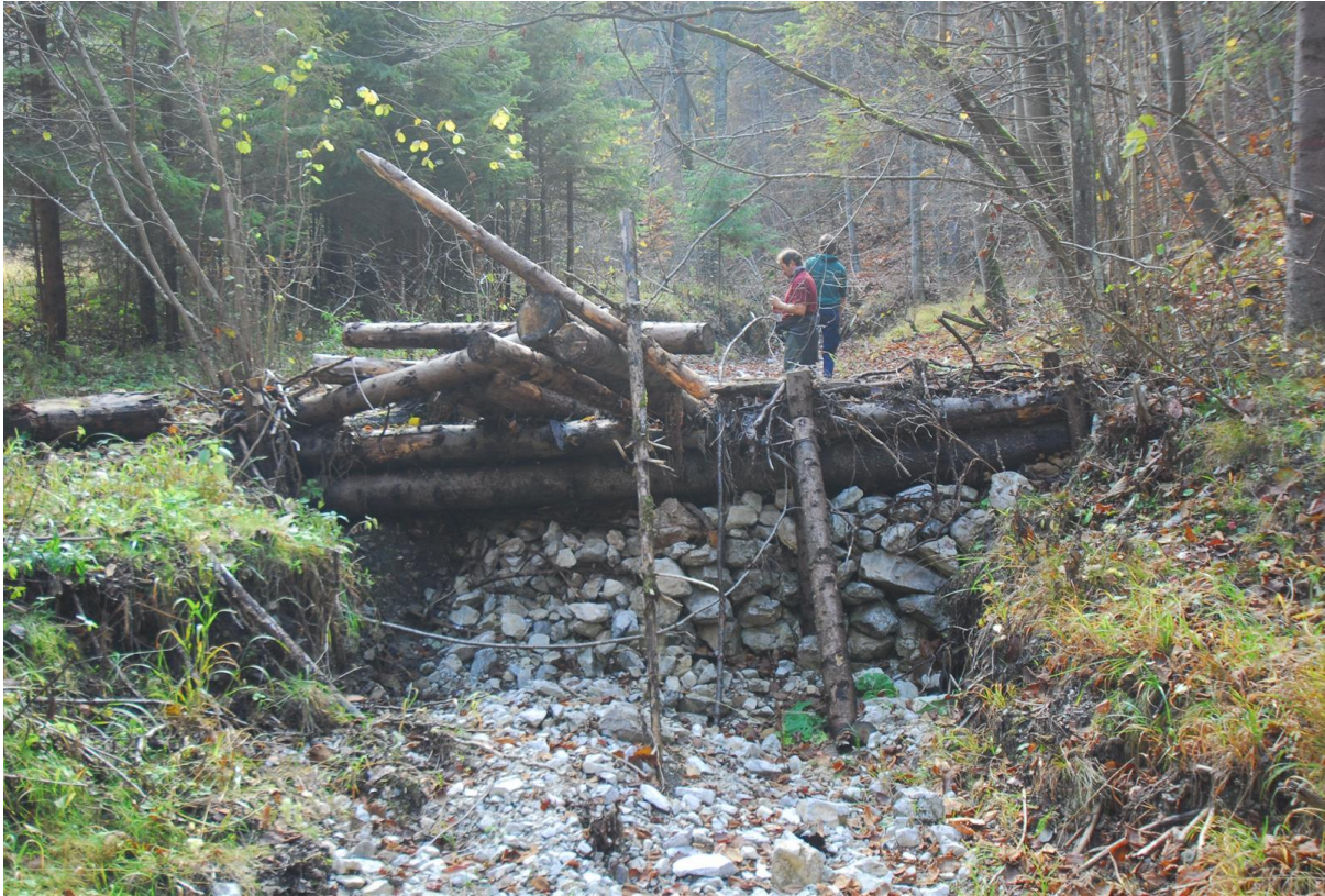
Terskelen har tålt en trøkk
